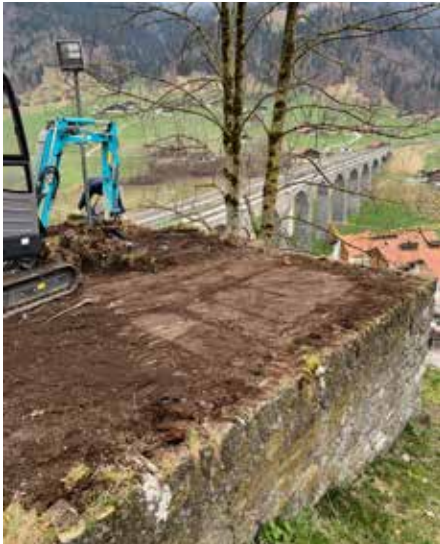
Hier werden die neuen Sanitäranlagen erstellt.
