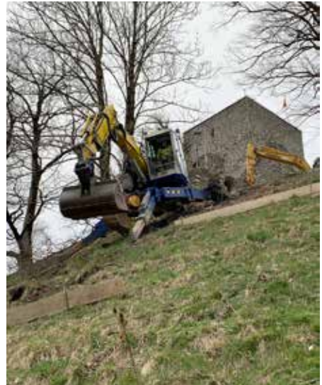
Der Graben für die Kanalisation führt steil hinunter.
