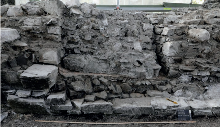
Abb. 5: Die Schiesscharte mit den konisch nach Süden laufenden Laibungen rechnet mit der Mauer (1) aus dem 13. Jahrhundert. Der Mörtelstrich auf der Sohle gibt in etwa an, auf welcher Höhe sich das mittelalterliche Bodenniveau befand. Interessant ist, dass die Öffnung bereits im 15. Jahrhundert verschlossen wurde.
