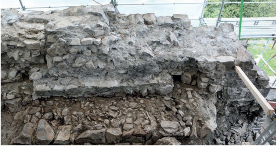
Abb. 3: Auf dem Bild gut zu erkennen die Sanierung der 1930-Jahre. Da dieser Mauerbereich keine Schäden aufweist und keine Schädigung des historischen Mauerwerks verursacht, wird er nicht abgebrochen.
