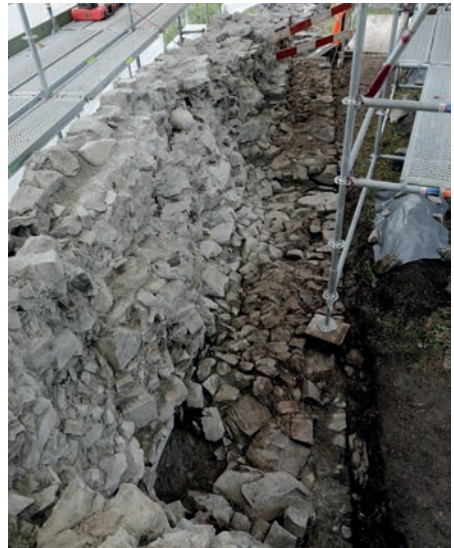
Abb. 4: Nur wenige Zentimeter unterhalb der heutigen Grasnarbe zeigte sich die Abbruchkrone der Mauer (11). Sie dürfte aufgrund des Mauercharakters ins 13. Jahrhundert datieren. Nach der Übernahme durch die Berner wurde die 210 cm mächtige Mauer bis auf Höhe des Innenhofs angebrochen und ab hier in deutlich reduzierter Mauerstärke wieder aufgebaut.
