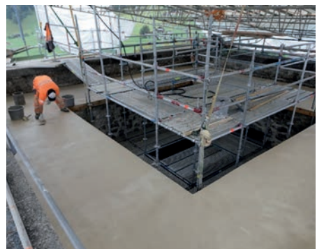
Abb. 1: Neuer Überzug auf der Turmplattform als Unterlage für den definitiven Gehbelag.
