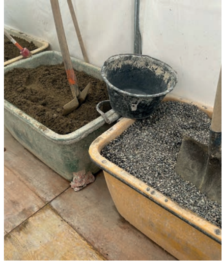
Der Baustoff: Spezialmörtel wie im Mittelalter.
