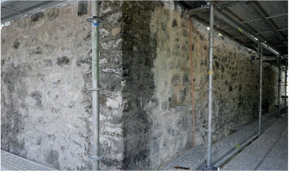
Abb. 2: Sanierte Mauerecke am Turm
