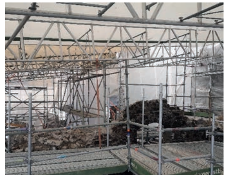
Abb. 4: Mauern (12/14) bereit für die definitiven Maurerarbeiten im 2026.
